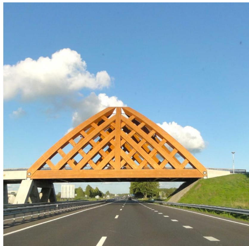
Afbeelding 4: De houten brug boven de A7 bij Sneek, geschikt voor alle soorten verkeer.
