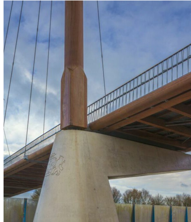
Afbeelding 6: Houten Botterbrug voor fietsverkeer in Harderwijk.
